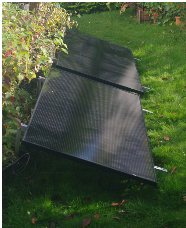
Abbildung 1: Die Standardoption der recht flachen Aufstellung. Durch die niedrig stehende Sonne waren die Module in dieser Aufstellung leider zu lange beschattet.
