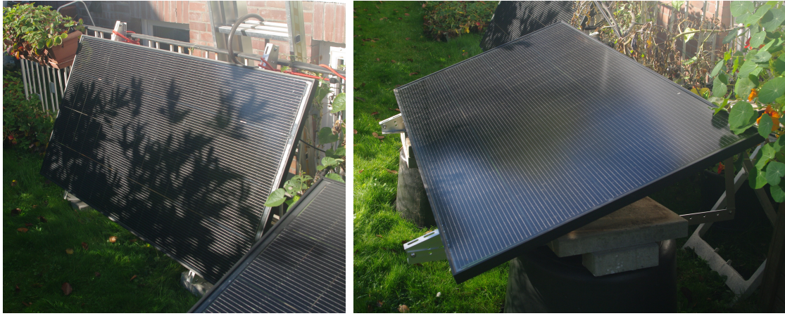
Abbildung 2: Ein Modul wurde fast senkrecht auf die kurze Seite der dreiecksförmigen Halterungen gestellt (links), was mit einer zusätzlichen Befestigung an einem Geländer ausreichend stabil war. Das andere Modul (rechts) wurde wieder flach, aber etwas erhöht aufgestellt.
