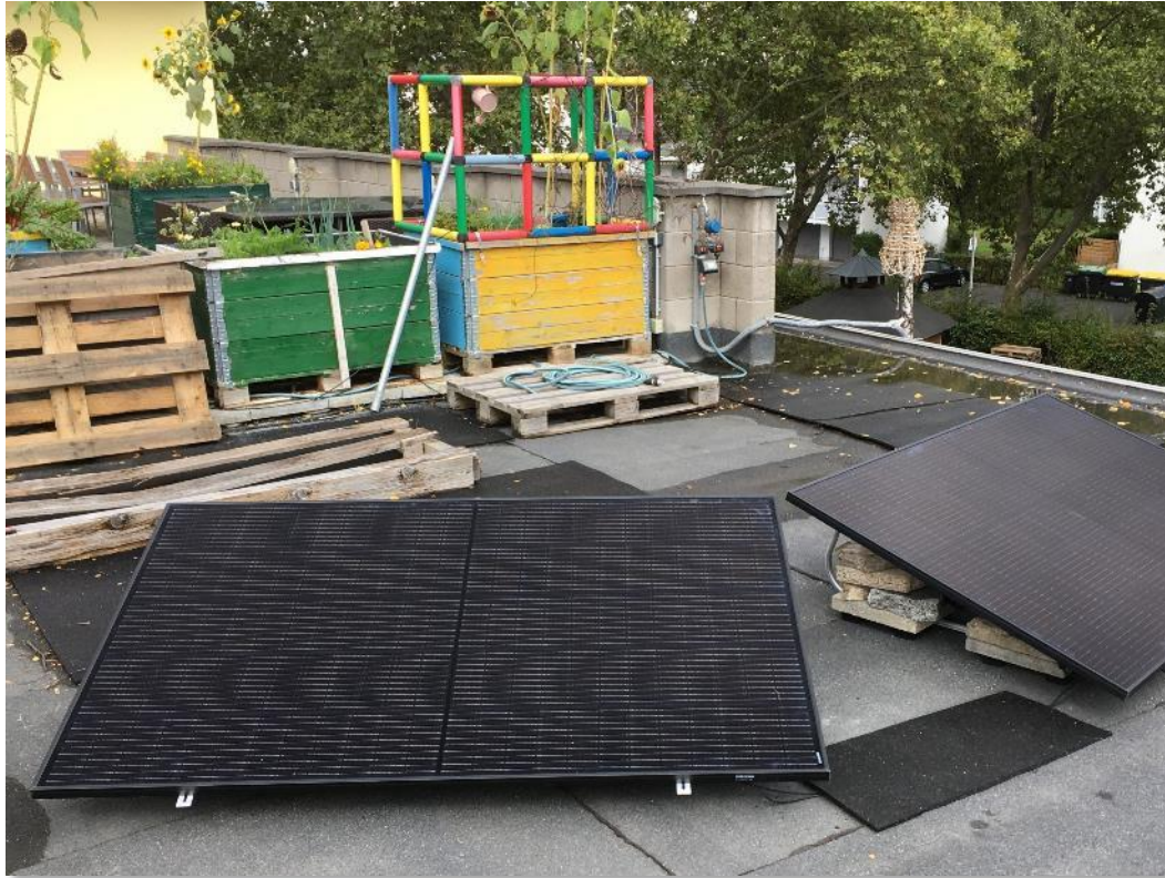
Dachgarten Mühlenbachhalle, Vilich-Müldorf
