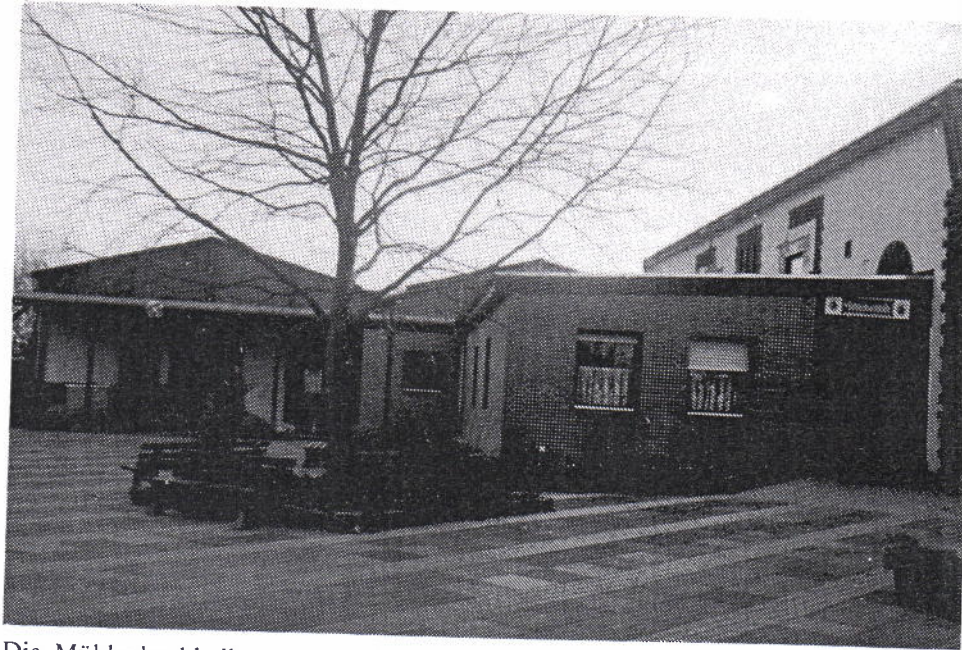
Die Mühlenbachhalle — ein sichtbarer Beweis für den Gemeinschaftssinn unseres Dorfes. Die Halle wurde hauptsächlich in Eigenleistung gebaut
