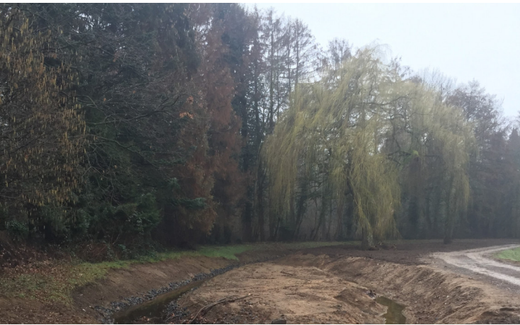
Der neue Bachlauf in der Bauphase
